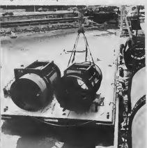
SECTIONNAN DI seccionnan a worde hisa cu facilidad for di dek di e bapor di carga y deposita ariba e lancha door di e grua di e bapor.
